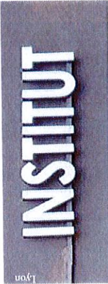
lettres boîtier fixées sur une lisse
