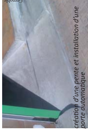
porte en retrait - pente anti-dérapante
